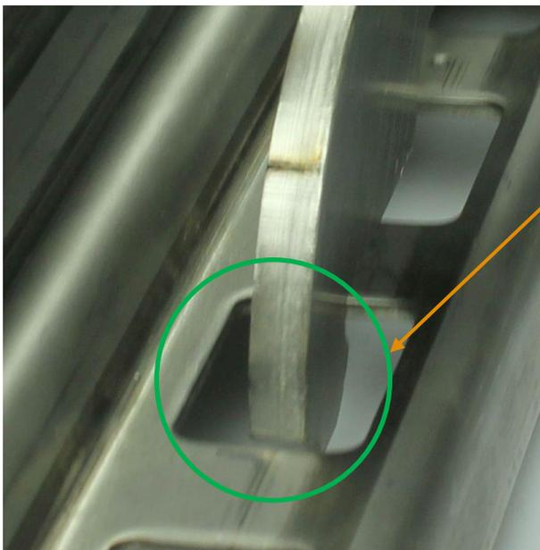
Position correcte du doigts de verrouillage bloqué dans le rail Frigowall.
