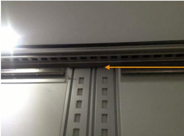
Um den Höhenverlust möglichst gering zu halten, endet die Doppelstock-Schiene innerhalb der IsoLok-Schiene.
